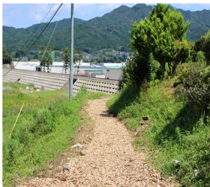
▲第二期整備後の「結の道」
