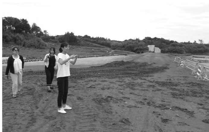
今年、初めて福島県浜通りを南北に縦断して復興工事現場取材した。
