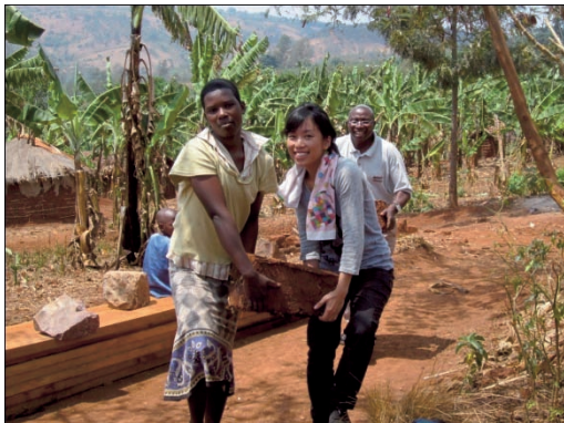
和解の家造りプロジェクトで日干しレンガを運んでいます
