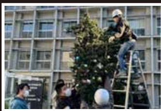
イルミネーション設置作業
