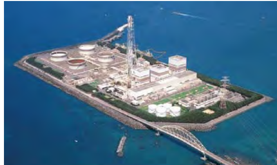
関西電力 御坊発電所 https://www.kepc.co.jp/energy_supply/energy/thermal_power/plant/gobo.html (2019/1/10アクセス)
