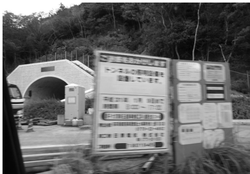
写真③建設中の新たなトンネルとバイパス 資料：著者撮影（2018年11月1日）
