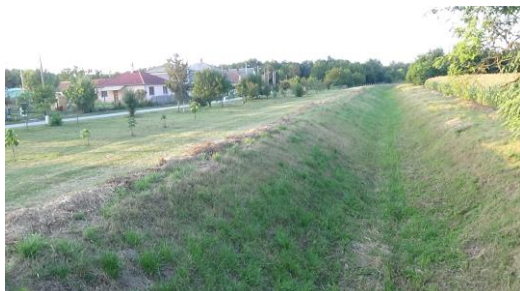
【写真2】フェレジュド村入り口の水路（9月撮影時には、水の流入は確認できなかった）
